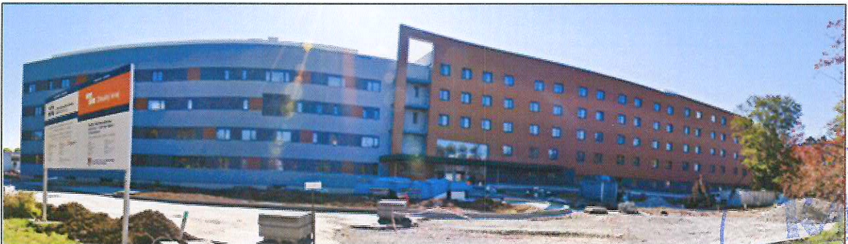
Říjen 2013 – Budova centrálního objektu získává jasnější obrys
