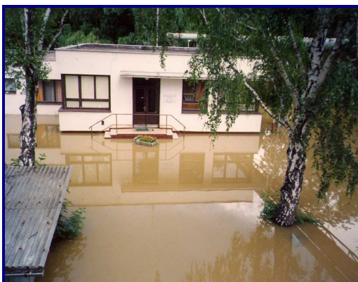
Zaplavený areál nemocnice v roce 1997
