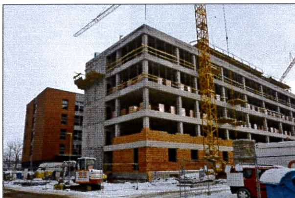
Prosinec 2017 – dokončování monolitické konstrukce interního pavilonu
